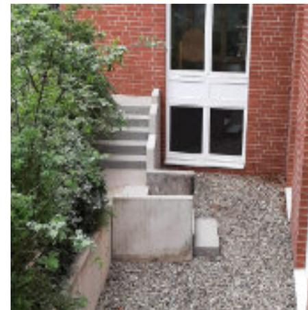
*Eine neue Treppe kann vom Untergeschoss notfalls als Fluchtweg dienen. Der Handlauf wird noch angebracht.*
